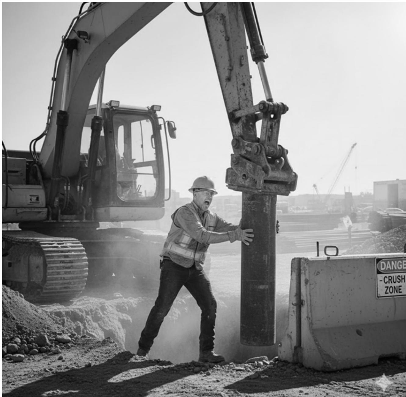
Sur l'image, le travailleur se tient directement dans la zone d'écrasement d'un accessoire d'excavatrice en fonctionnement, les mains posées sur le composant en
