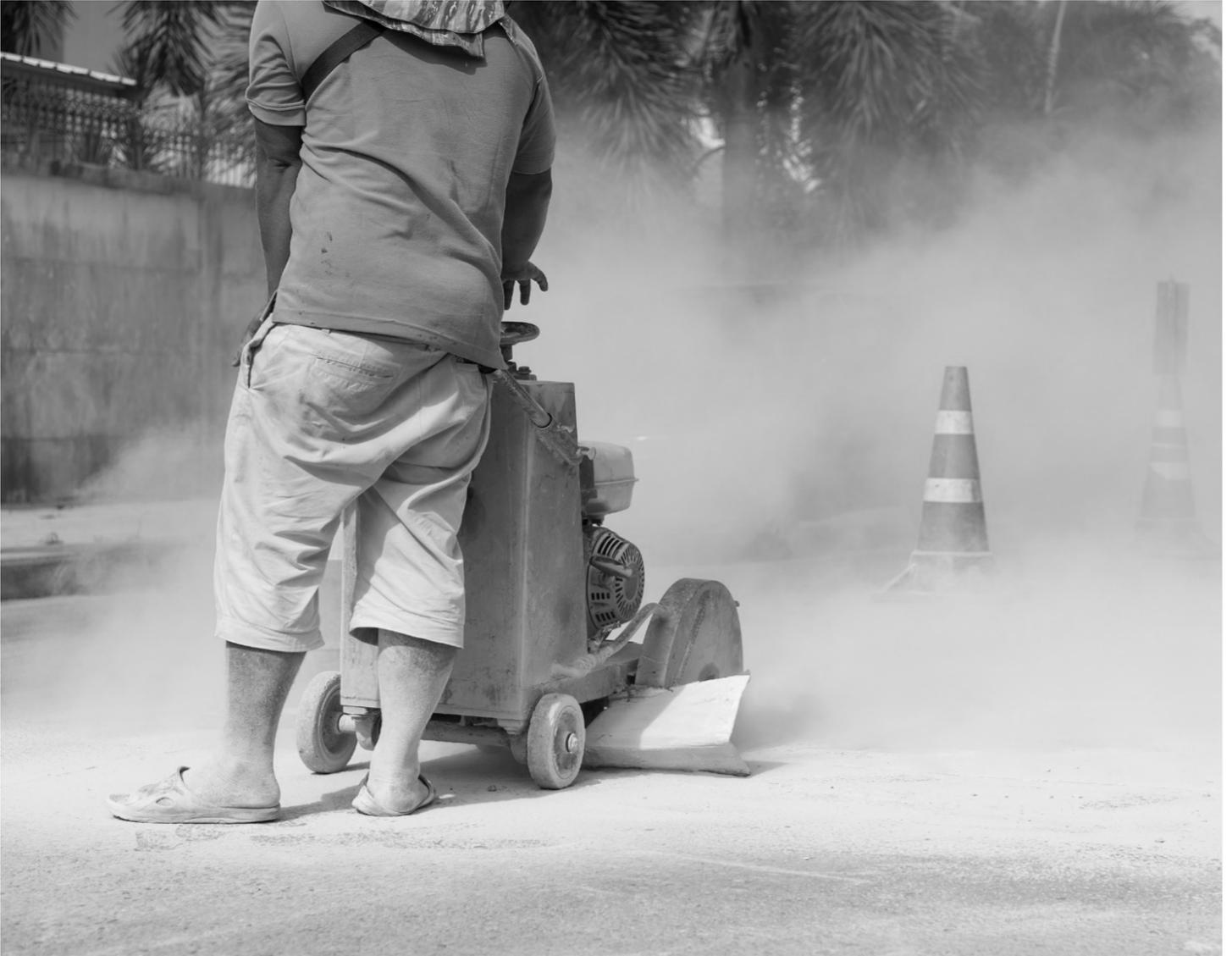
Sur l'image, un travailleur utilise une machine à couper le béton dans un nuage de poussière sans aucun équipement de protection individuelle (EPP) visible. Le travailleur est exposé à la silice cristalline alvéolaire, qui peut provoquer de graves maladies pulmonaires telles que la silicose. En outre, la personne porte des chaussures ouvertes et pas de gants, ce qui rend ses pieds et ses mains vulnérables aux débris tranchants ou au contact avec la machine.
