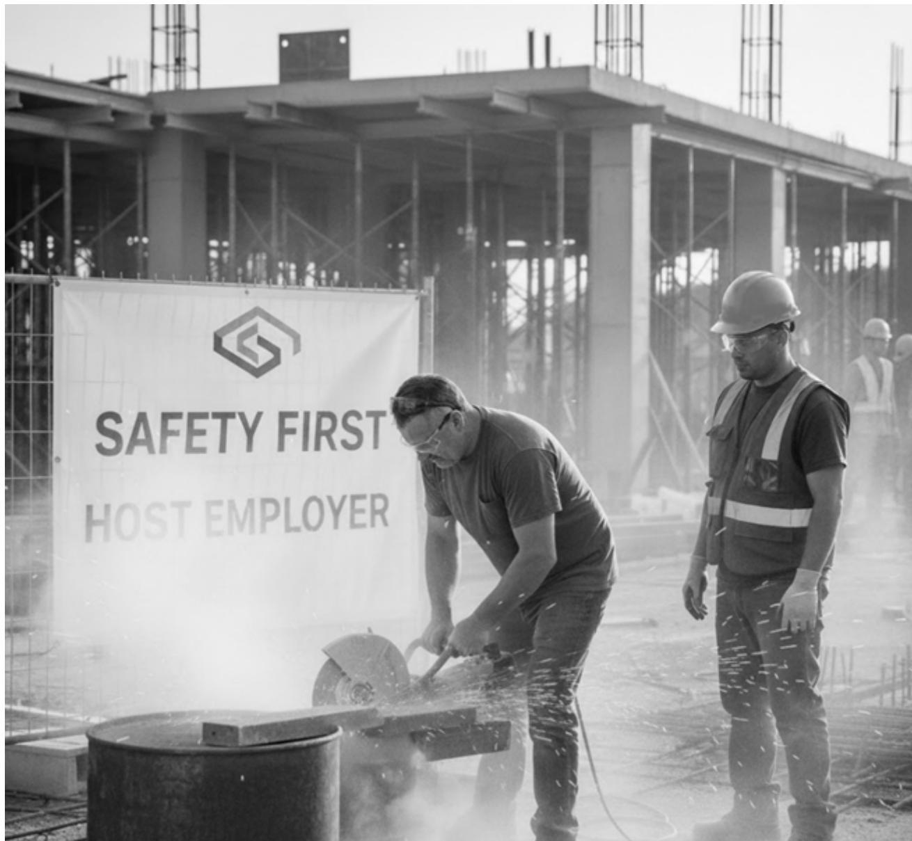
Sur la photo, l'entrepreneur coupe du métal à l'aide d'une scie électrique, produisant d'importantes étincelles et de la poussière, mais il ne porte pas l'EPP requis : pas de visière, pas de protection auditive et pas de protection respiratoire. Il travaille à quelques centimètres d'un autre sous-traitant qui ne porte pas non plus l'EPP adéquat et se tient directement dans la trajectoire des
