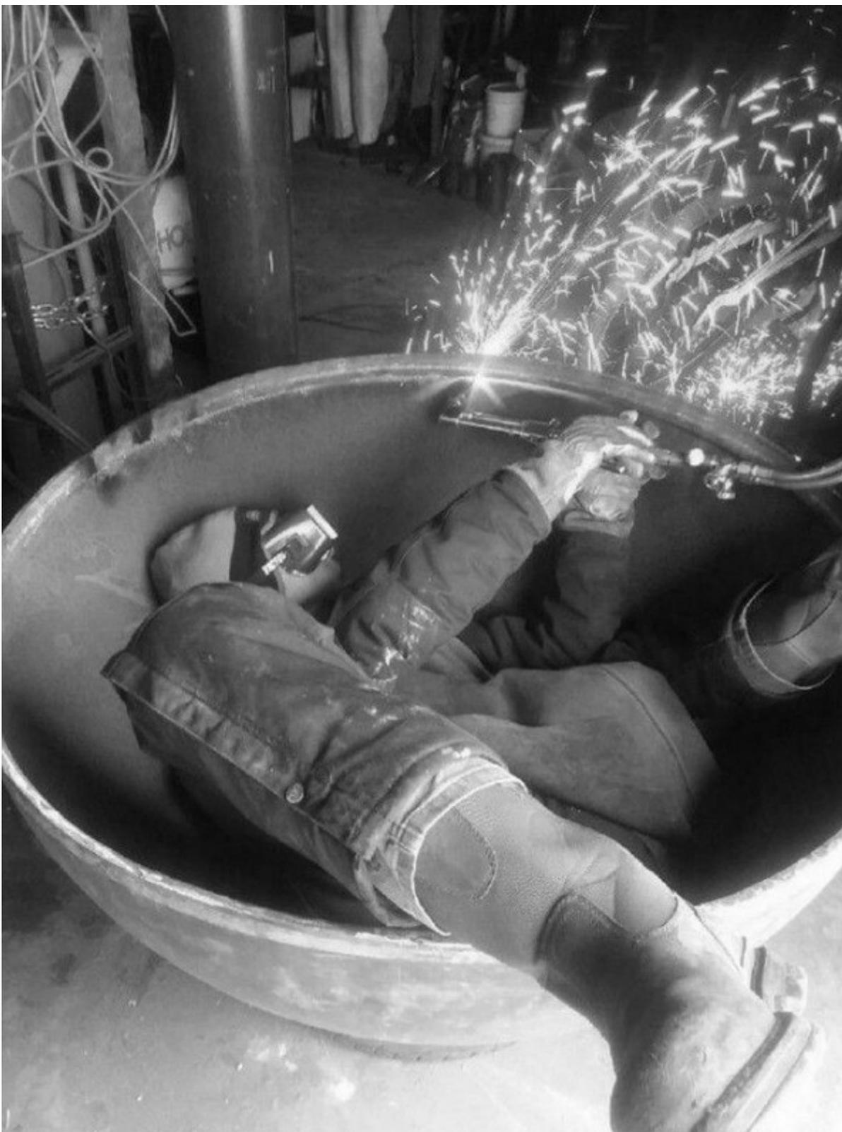
El trabajo en caliente puede lanzar chispas y material fundido a más de 35 pies durante la soldadura, el corte y el amolado. Estas chispas y la escoria caliente suelen arder a más de 1.000 °F, lo que es más que suficiente para encender fácilmente el papel, la madera, los líquidos inflamables, los vapores y cualquier otro combustible en la zona.
