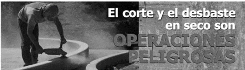
**L**a nube de polvo que se ve cuando un obrero realiza operaciones de corte o desbaste de concreto, ladrillo o piedra no es simplemente nube inocua... Contiene silice cristalina... y PUEDE SER MORTAL.
