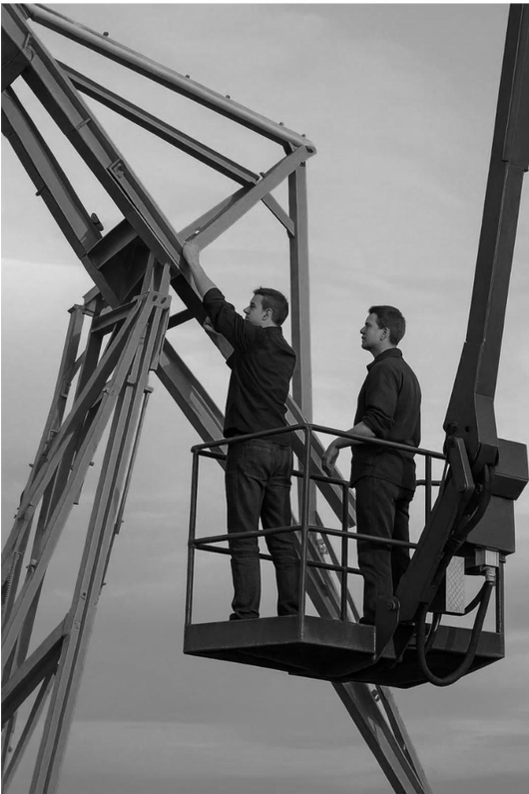
Cette image montre deux travailleurs sur une plate-forme élévatrice mobile de personnel (PEMP), mais plusieurs problèmes de sécurité sont visibles. Aucun des deux travailleurs ne porte de harnais de sécurité ou de système antichute, ce qui est essentiel pour travailler en hauteur sur une PEMP. En outre, ils semblent se tenir très près du bord, sans ancrage ni protection appropriés.
