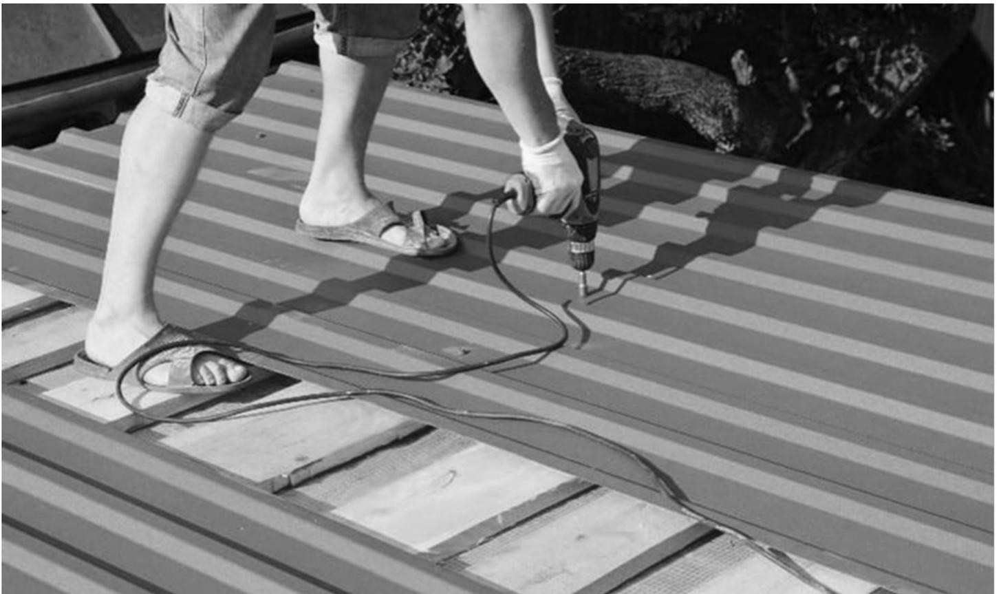
En la imagen, una persona está de pie sobre un techo metálico mientras utiliza un taladro eléctrico. Sin embargo, lleva sandalias abiertas, está de pie sobre una superficie inestable sin protección visible contra caídas y maneja equipos eléctricos con cables expuestos. Esta situación presenta múltiples riesgos graves, entre ellos el riesgo de caídas, electrocución y lesiones en los pies por herramientas o materiales.
